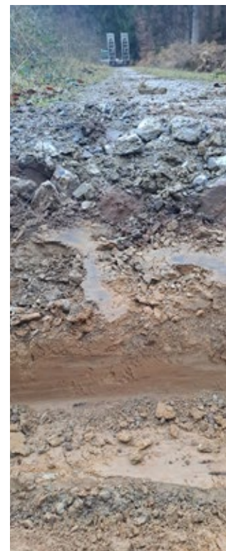
CA. 30 CM UNTER DER WEGEROBERFLÄCHE BEFINDET SICH BEREITS EINE MÄCHTIGE LEHMSCHICHT. DIE URSPRÜNGLICH GEPLANTE WEGEVERLEGUNG WURDE DARAUFIN KURZFRISTIG GESTOPPT. FOTO ANNE WITTENBERG
