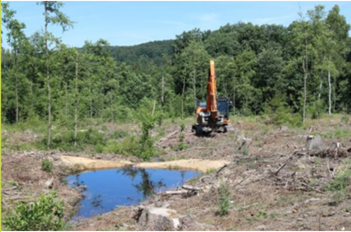
DURCH DIE KAMMERUNG DES GRABENS IM TEILGEBIET 2 ENTSTEHEN TEMPORÄRE GEWÄSSER. IM ANSCHLUSS AN DIE SANIERUNG DER DÄMME WURDE ZU DEREN VERANKERUNG EINE GRASNARBE AUFGESETZT. FOTO: HEIKO BREDE
