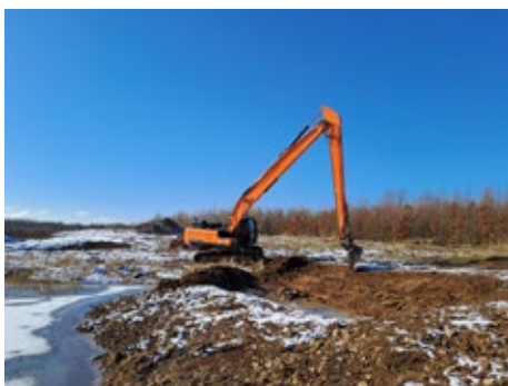
ANLAGE VON TEICHEN NEBEN DEM EHEMALIGEN GRABEN, MIT EINBAU VON STEINEN ZUM SCHUTZ VOR FRESSFEINDEN, FOTOS: MAREN AMMER
