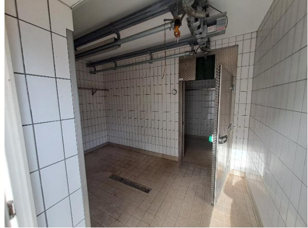
Nebengebäude Vorraum Kühlraum
