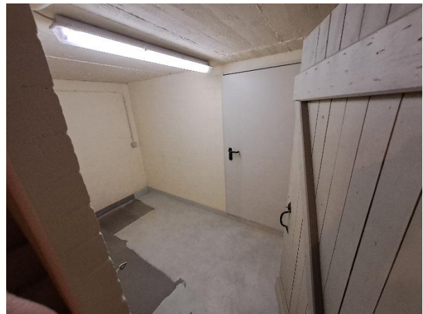
Keller Pelletlager (hinter Stahltür)
