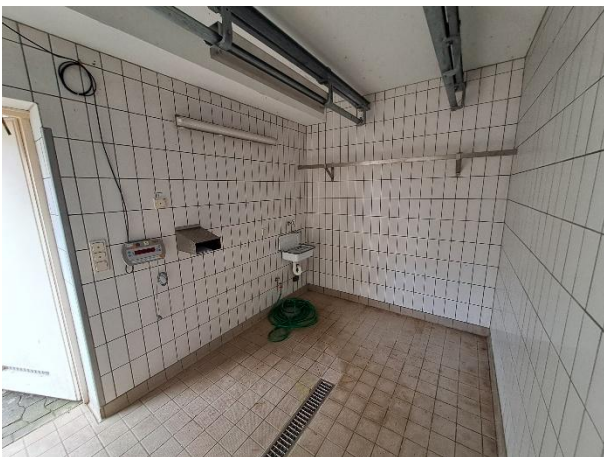
Nebengebäude Vorraum Kühlraum
